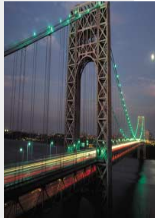
Vorhandene Kapazitäten doppelt nutzen: doppelter Output und mehr.
